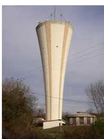
Cette usine de production est composée de 2 forages Caplande 1 et 2, d'une station de reprise équipée d'une bache de 250 m<sup>3</sup> et du château d'eau du Teich d'une capacité de 650 m<sup>3</sup>.
