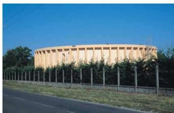
Cette usine de production est composée de 2 forages La Hume 1 et 2 et d'une station de reprise équipée d'une bache de 1000 m<sup>3</sup>.
