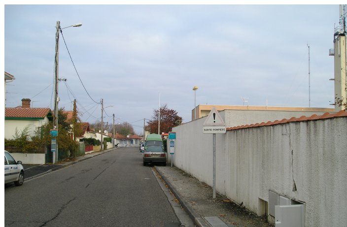
Arrêt en ITA sur critère de largeur insuffisante à La Teste de Buch (Commissariat)
