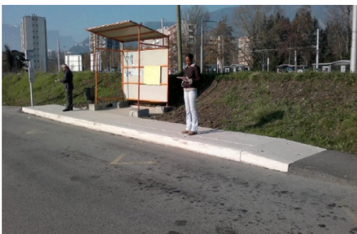
Terminus provisoire d'une ligne de bus dans l'attente d'un réaménagement urbain (commune de Saint-Martin d'Hères)
