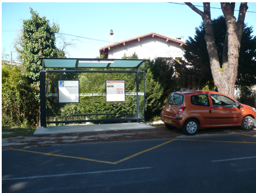
Marquage au sol en bon état (Port de La Teste)
