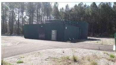
Cette station est composée d'un surpresseur équipé d'une bâche de 620 m<sup>3</sup> et de 3 pompes à vitesse variable. Il assure l'alimentation des réseaux des quartiers de Sylvabelle, Balanos et Lamothe sur l'est de la COBAS.
