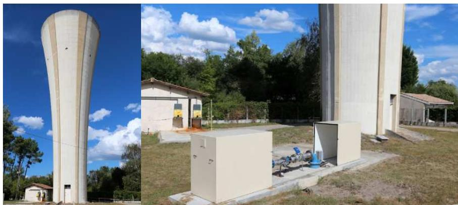
Cette usine de production est composée de 2 forages Caplande 1 et 2, d'une bâche de 250 m<sup>3</sup>, de 2 pompes de reprise et du château d'eau du Teich d'une capacité de 650 m<sup>3</sup>.
