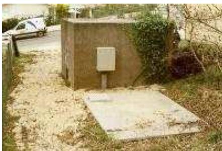
Il s'agit d'un surpresseur en ligne avec 2 pompes à vitesse variable alimentant le point haut de ce quartier. Il a été construit en 1999 et mis en service en 2000 en remplacement du surpresseur « Portes de l'Océan ».
