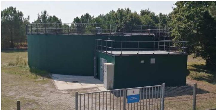
Cette station de production est composée du forage de Villemarie avec chloration, d'une bache de 1000 m3 et de 3 pompes de reprise.
