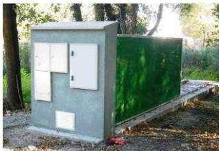
Afin d'assurer l'alimentation et la défense incendie du réseau d'alimentation de la zone de Camicas, un surpresseur est installé sur le réseau de distribution de La Teste de Buch.
