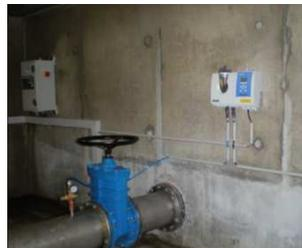
Cette station n'est composée que d'une bache d'une capacité de 5000 m3 avec un traitement au chlore gazeux.
