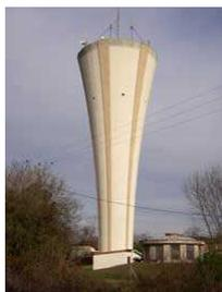
Cette usine de production est composée de 2 forages Caplande 1 & 2 (voir plus haut), d'une station de reprise équipée d'une bache de 250 m<sup>3</sup>, et du château d'eau du Teich d'une capacité de 650 m<sup>3</sup>.
