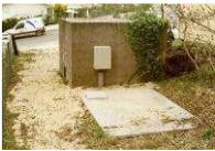
Il s'agit d'un surpresseur en ligne avec 2 pompes à vitesse variable permettant de maintenir le point haut de ce quartier. Il a été construit en 1999 et mis en service en 2000. Il a été remplacé par le surpresseur « Portes de l'Océan ».
