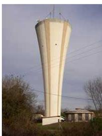
Cette usine de production est composée de 2 forages Caplande 1 et 2, d'une bâche de 250 m<sup>3</sup>, de 2 pompes de reprise et du château d'eau du Teich d'une capacité de 650 m<sup>3</sup>.
