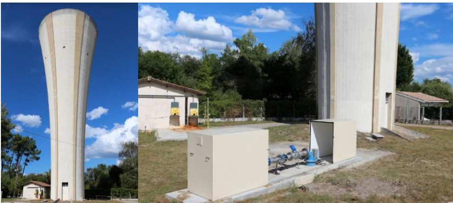
Cette usine de production est composée de 2 forages Caplande 1 et 2, d'une bache de 250 m3, de 2 pompes de reprise et du château d'eau du Teich d'une capacité de 650 m3.
