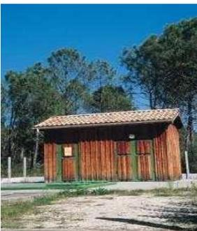
Cette station est composée d'un surpresseur équipé d'une bache de 300 m<sup>3</sup> et de 3 pompes à vitesse variable. Il assure l'alimentation des réseaux des plages océanes et le Pyla surpressé (en secours, lorsque la vanne automatique des Pompiers du Pyla est ouverte).
