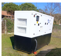
Installation en 2024 d'un groupe électrogène sur le site Cazaux lac
