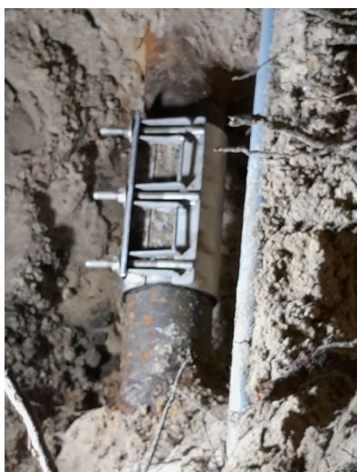
Fuite Fonte grise DN100 - Case franche - Coquille de réparation
