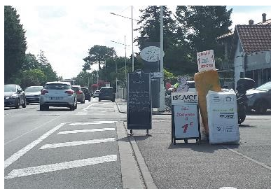
Obstacle sur un cheminement
