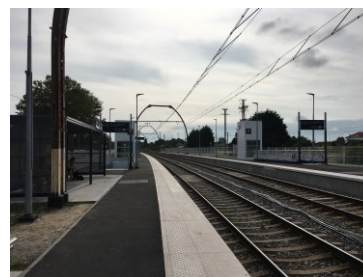
Marquage tactile et visuel
