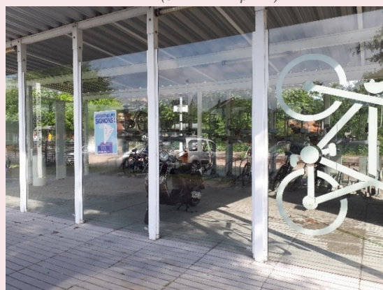
Exemple de stationnement vélo sécurisé à la gare de la Hume (Source : Explain)
