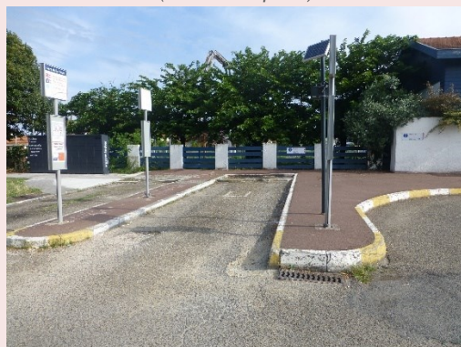
Arrêt de bus non conforme - COBAS (Source : Explain)
