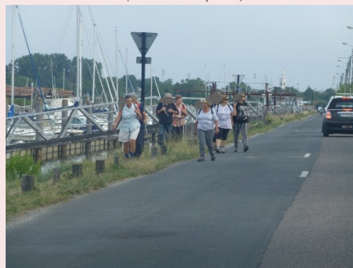
Une absence de cheminement piéton - COBAS (Source : Explain)
